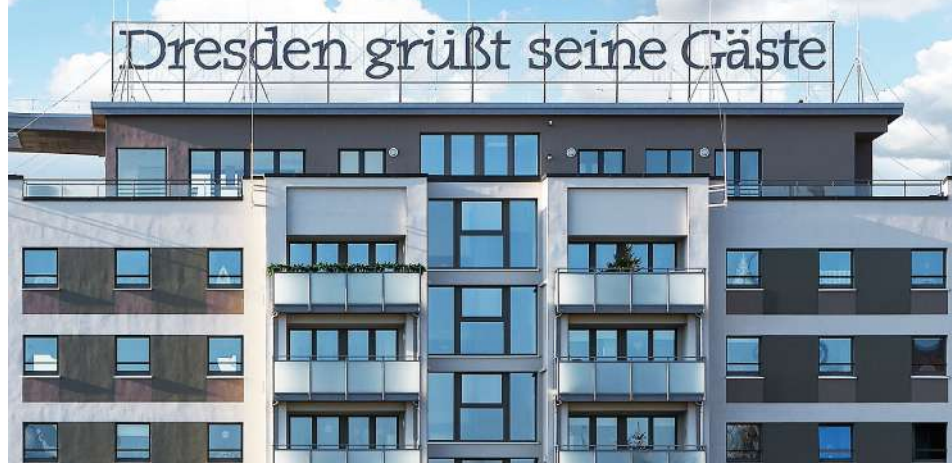
Sanierung & Neubau / Freiburger Straße 2-6 (a-c) 223 Eigentumswohnungen
