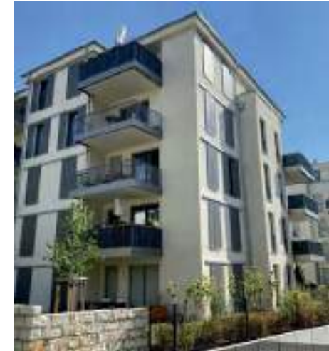
Turnerweg 2-4 31 Eigentumswohnungen Fertigstellung 2019
