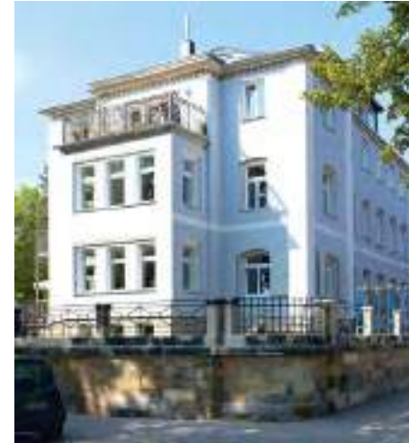
Lessingstraße 1 7 Eigentumswohnungen Fertigstellung 2012
